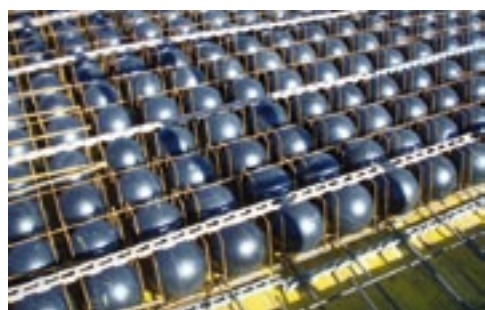
Slika 120: Sistem Cobiax pred vlivanjem betona.
